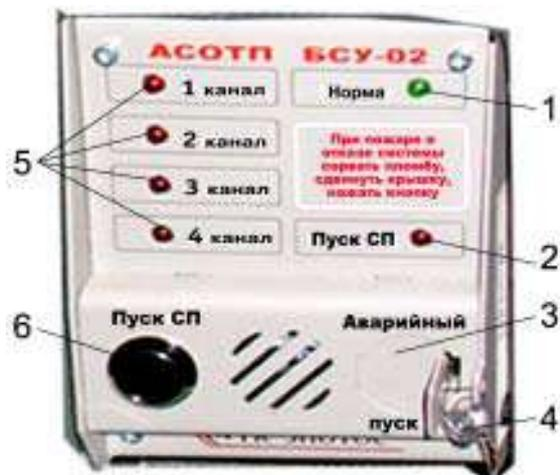
Рис. 1.68. Пульт блока сигнализации и управления АСОТП:
